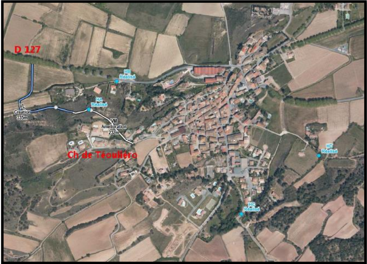
Les travaux-mesures de protection réalisés.
